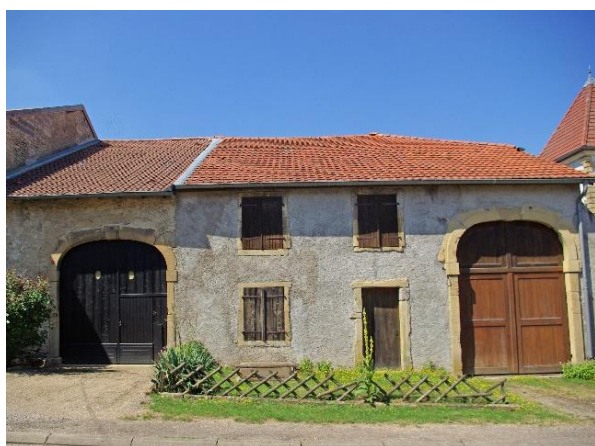
VARIZE-VAUDONCOURT – FAÇADE EN TROIS TRAVEES ET PORTES EN ARC APLATI DIT EN « ANSE DE PANIER »
