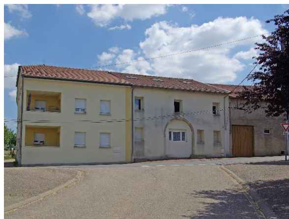
HELSTROFF – FENETRE INTEGREE A LA FAÇADE AU NIVEAU DE L'EMPLACEMENT DE L'ANCIENNE PORTE DE GRANGE
