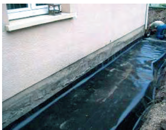
Figure 22 Géomembrane en cours de pose (Source Socabat)
