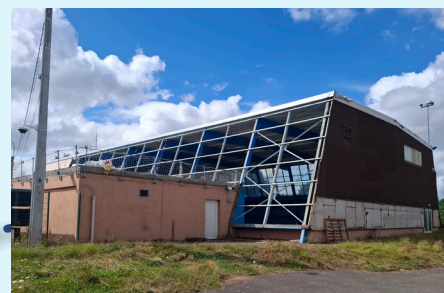
02/04 : Lancement des travaux de rénovation du gymnase intercommunal à Falck pour une durée prévisionnelle de 9 mois
